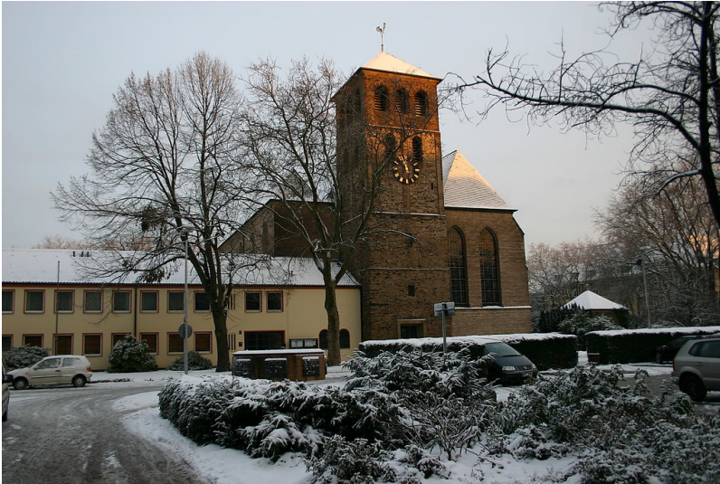
Das Kirchengebäude der ehemaligen Prämonstratenserabtei St. Johann in Duisburg-Alt-Hamborn (2010). Fotograf/Urheber: BlackIceNRW
