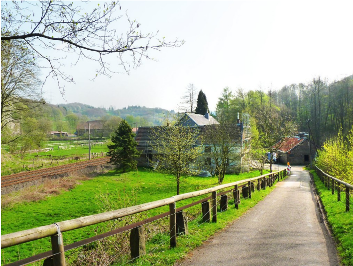
Das Gebäude des Dampfhammers im Deilbachtal (2011) Fotograf/Urheber: Gregori, Jürgen
