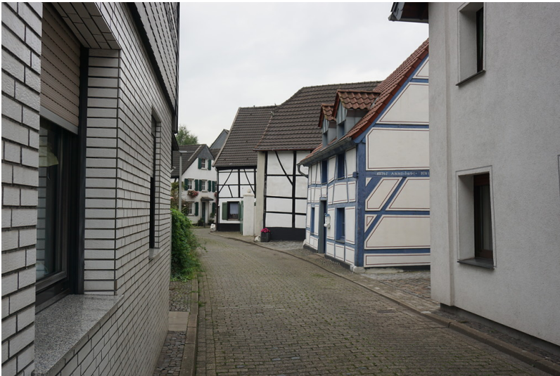
Oberhausen-Holten, Historische Altstadt, Krumme Straße (2017) Fotograf/Urheber: Claus Weber
