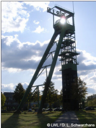
Einzelobjekt 5 Fördergerüst „Erin VII“ (Foto 2009): Das Fördergerüst für den Schacht „Erin VII“ ist eines der wenigen Bauwerke, die hier heute noch an den Standort der Zeche Erin erinnern. Die Konstruktion ist inzwischen zum Merkmal und zugleich zur Landmarke für den „Dienstleistungs- und Gewerbetpark Erin“ geworden.
