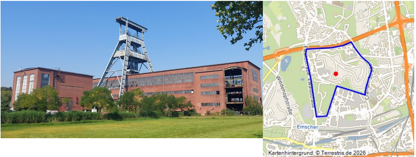
Förderturm (Doppelbock-Fördergerüst über Schacht 7) und Gebäude der Zeche Ewald in Herten (2023). Fotograf/Urheber: Franz-Josef Knöchel
