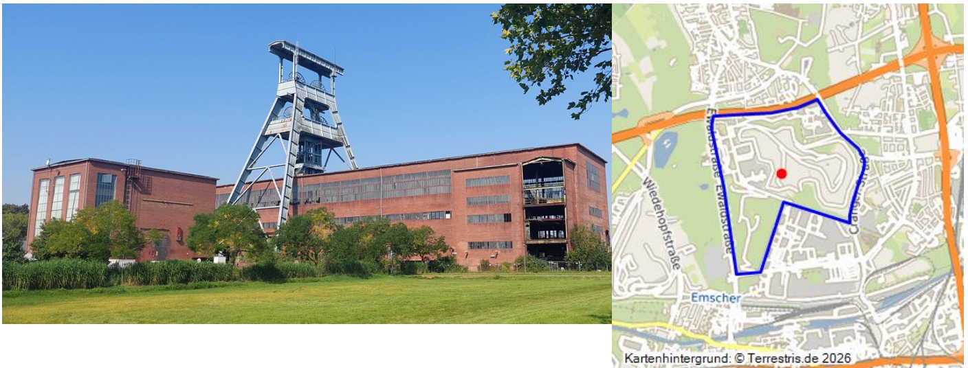
Fördererturm (Doppelbock-Fördergerüst über Schacht 7) und Gebäude der Zeche Ewald in Herten (2023). Fotograf/Urheber: Franz-Josef Knöchel
