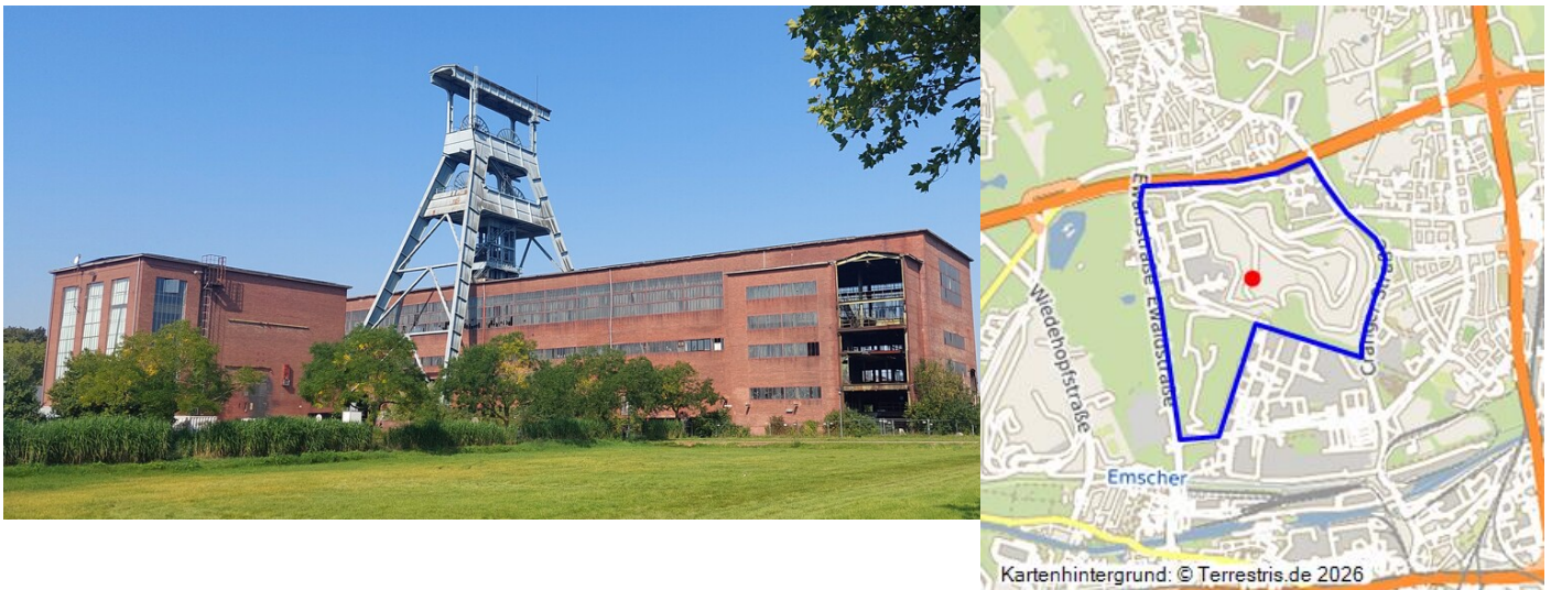
Förderturm (Doppelbock-Fördergerüst über Schacht 7) und Gebäude der Zeche Ewald in Herten (2023). Fotograf/Urheber: Franz-Josef Knöchel
