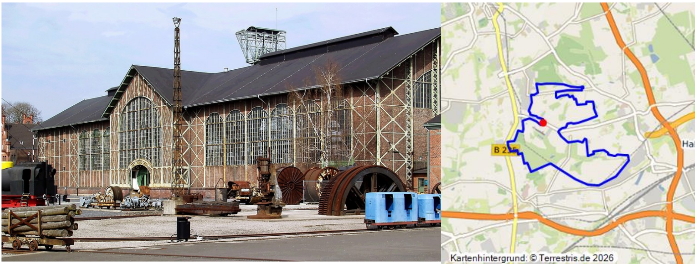
Maschinenhalle der früheren Zeche Zollern II/IV in Bövinghausen / Westrich (2002).
