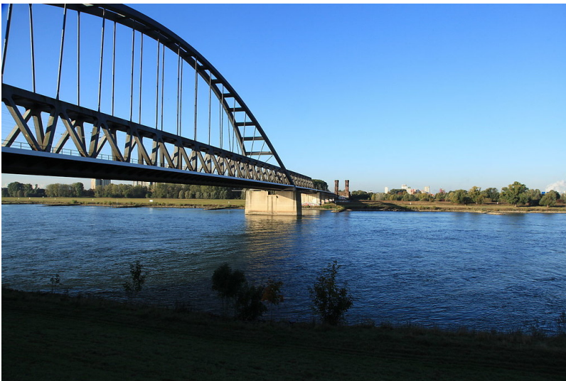
Die Hammer Eisenbahnbrücke zwischen Neuss und Düsseldorf (2012) Fotograf/Urheber: Frank Vincentz
