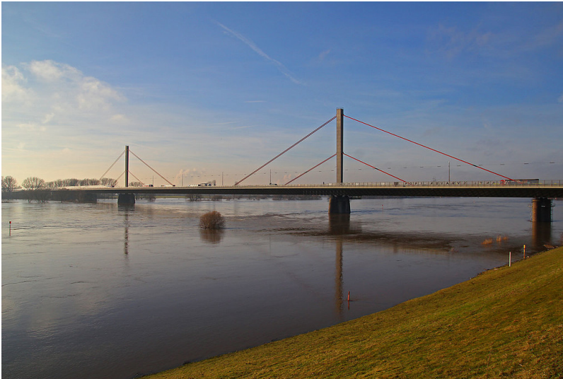
Die Rheinbrücke Leverkusen (Autobahnbrücke A 1) während eines Rheinhochwassers im Januar 2011. Fotograf/Urheber: A. Savin
