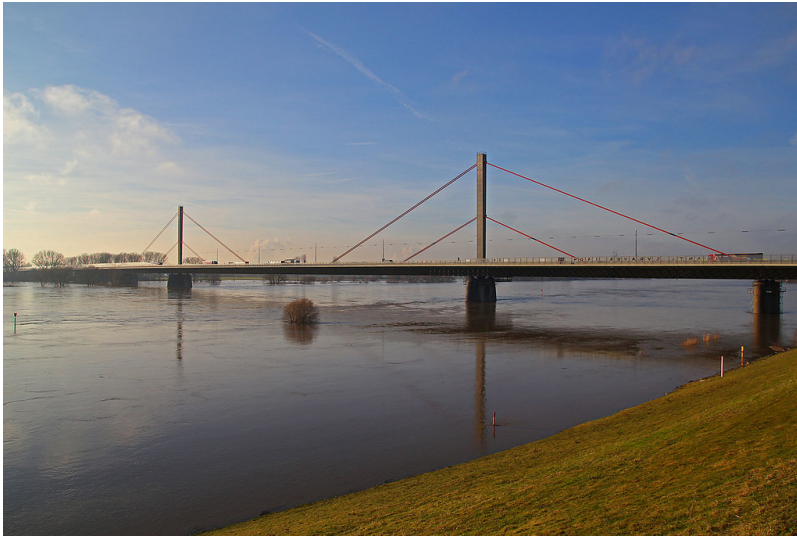
Die Rheinbrücke Leverkusen (Autobahnbrücke A 1) während eines Rheinhochwassers im Januar 2011. Fotograf/Urheber: A. Savin
