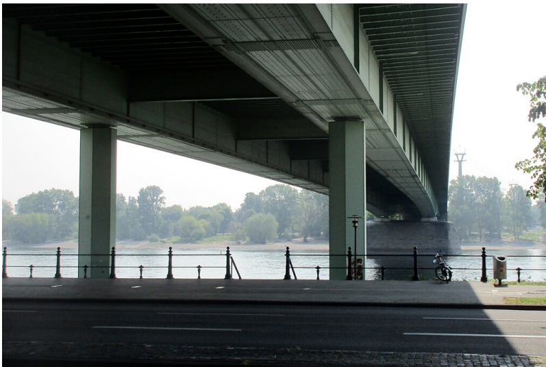
Blick vom Riehler Konrad-Adenauer-Ufer aus auf die Unterseite der Konstruktion der Kölner Zoo-brücke (2020). Fotograf/Urheber: Franz-Josef Knöchel
