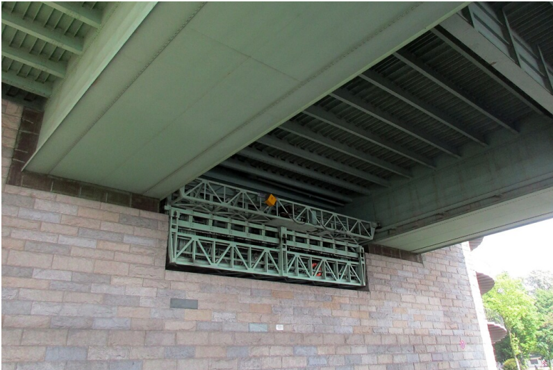
Blick vom Riehler Konrad-Adenauer-Ufer aus auf die Konstruktion des Kastenträgers der Kölner Zoo-brücke (2020). Fotograf/Urheber: Franz-Josef Knöchel
