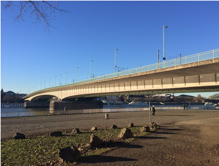
Blick auf die Deutzer Brücke in Köln (2016) Fotograf/Urheber: Jan Spiegelberg
