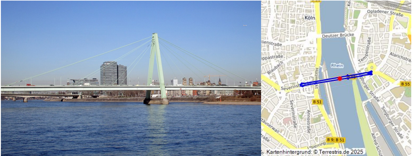
Blick auf Köln-Deutz mit Severinsbrücke und Hochhaus "Lanxess Tower" (2019). Fotograf/Urheber: Franz-Josef Knöchel
