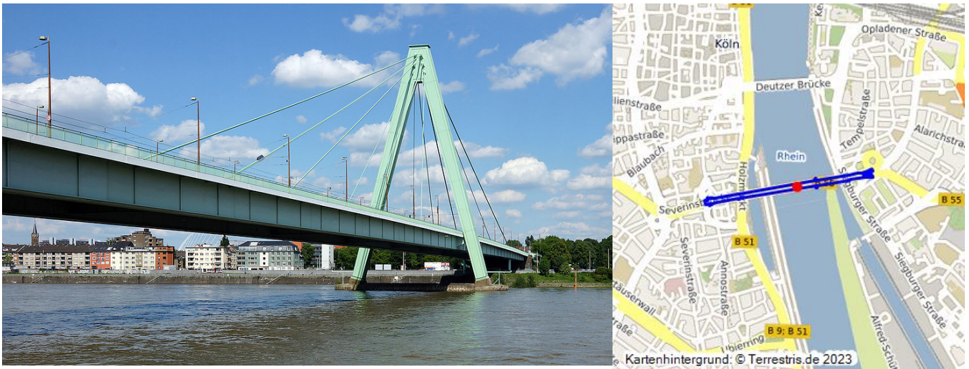
Die Kölner Severinsbrücke (Rheinbrücke Bundesstraße B 55) nach dem Abschluss von Sanierungsarbeiten in Blickrichtung Deutz (2013) Fotograf/Urheber: Rolf Heinrich
