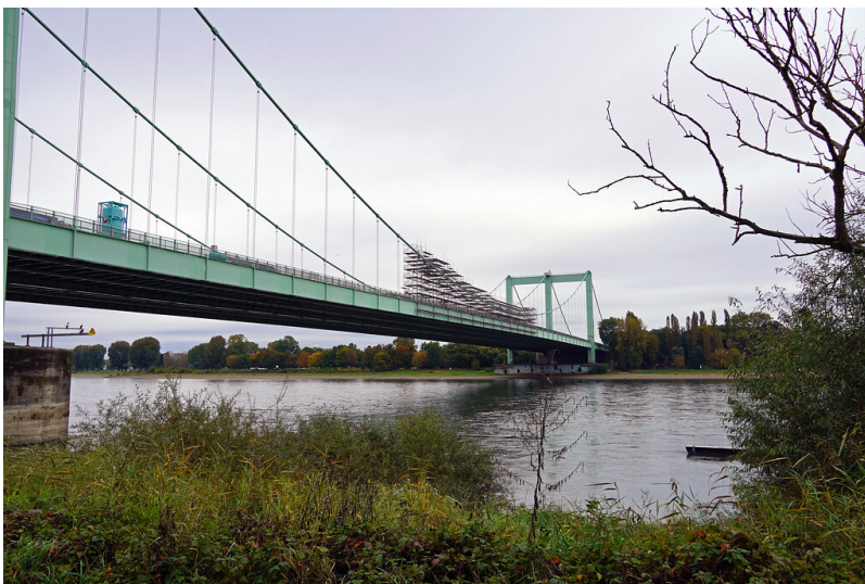
Blick auf die Rodenkirchener Autobahnbrücke mit Baugerüst in Köln-Rodenkirchen (2021). Fotograf/Urheber: Katharina Grünwald
