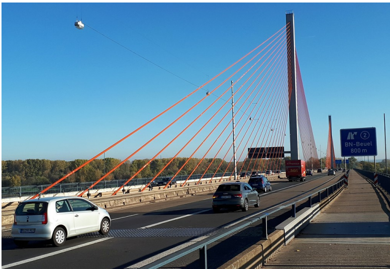
Blick auf die Fahrbahn der Bundesautobahn A 565 auf der Bonner Nordbrücke "Friedrich-Ebert-Brücke" (2017) Fotograf/Urheber: Franz-Josef Knöchel
