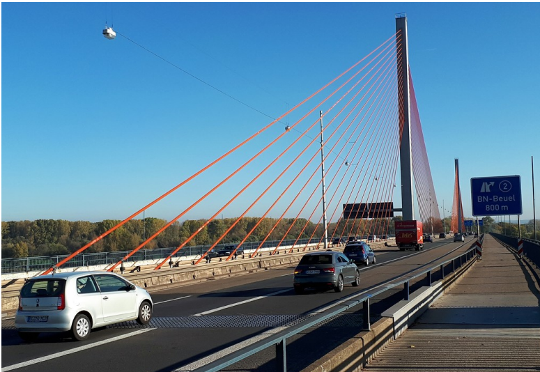
Blick auf die Fahrbahn der Bundesautobahn A 565 auf der Bonner Nordbrücke "Friedrich-Ebert-Brücke" (2017) Fotograf/Urheber: Franz-Josef Knöchel
