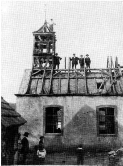
Historische Aufnahme (1916): Der Abriss der Kapelle von Bongard.
