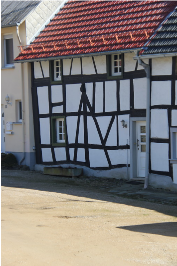
Fachwerkhaus in Bongard (2019) Fotograf/Urheber: Peter Burggraaff
