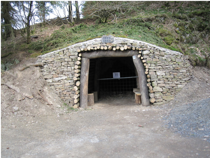
Eingang zum Schutzstollen bei Uersfeld (2010) - Station 20 der Geschichtsstraße, Abschnitt 1 Fotograf/Urheber: Peter Burggraaff
