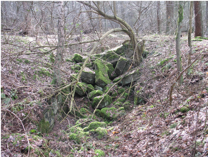
Reste eines gesprengten Bunkers der Verteidigungsanlage am Eltener Berg bei Emmerich (2010) Fotograf/Urheber: Wolfgang Wegener
