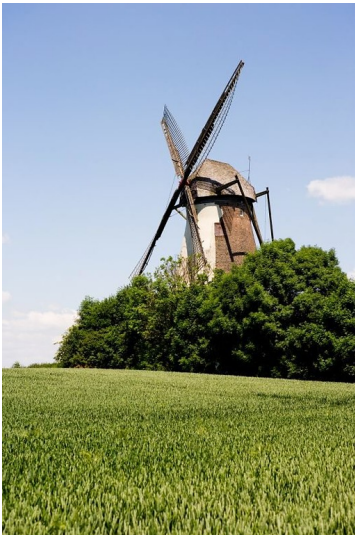
Grottenhertener Windmühle (2011) Fotograf/Urheber: Arendt, Stefan
