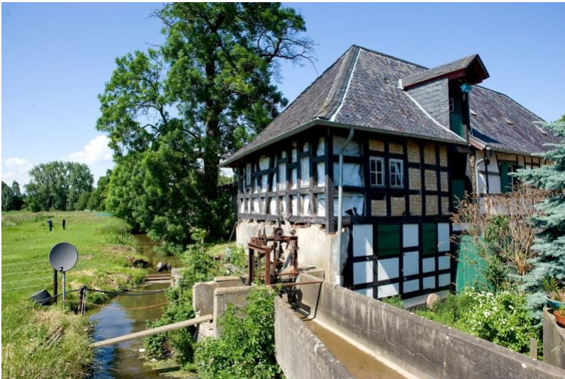
Das Fachwerkgebäude der Bliesheimer Mühle mit Mühlgraben und Zulauf Fotograf/Urheber: Pientka, Nicole
