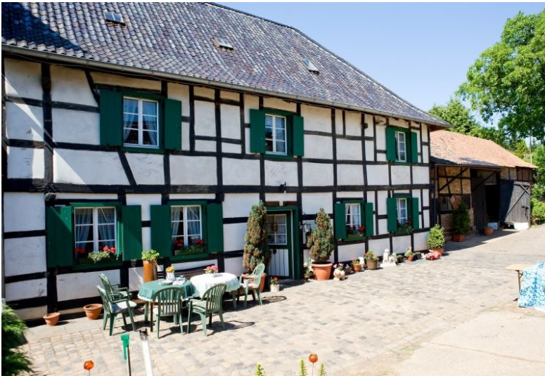
Fachwerkfront der Bliesheimer Mühle von der Hofseite aus gesehen Fotograf/Urheber: Arendt, Stefan
