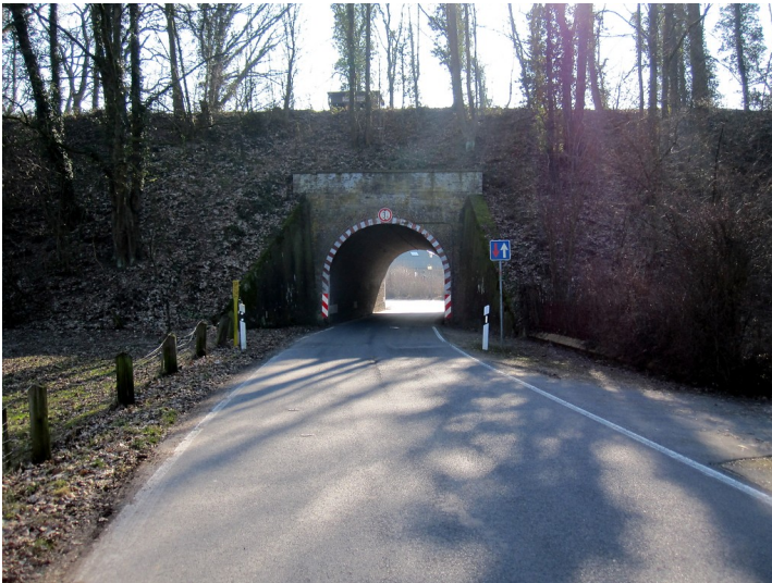
Unterführung im Bahndamm der Boxteler Bahn in Uedemerbruch für die Straße "Dorf" (2011) Fotograf/Urheber: Burggraaff, Peter
