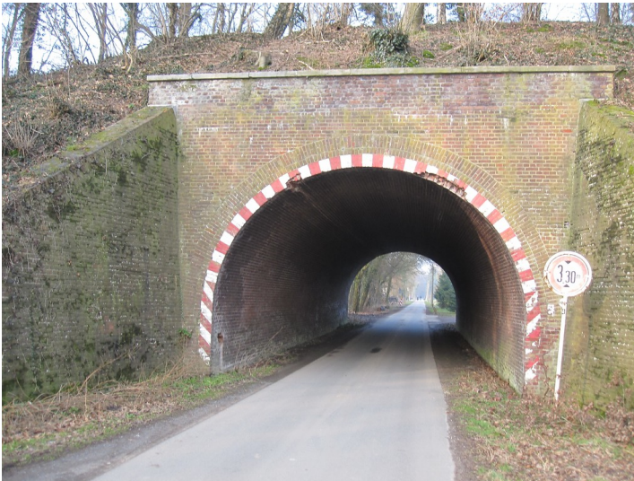
Bahnunterführung Holländerstraße in Uedemerbruch (2011) Fotograf/Urheber: Burggraaff, Peter
