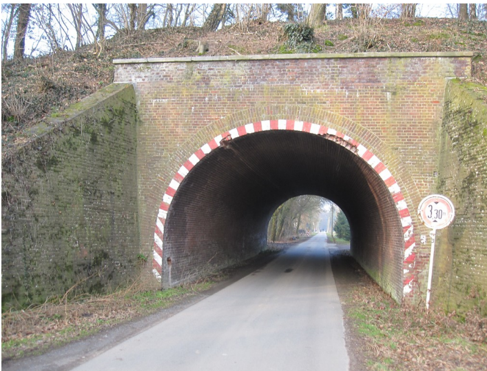
Bahnunterführung Holländerstraße in Uedemerbruch (2011) Fotograf/Urheber: Burggraaff, Peter
