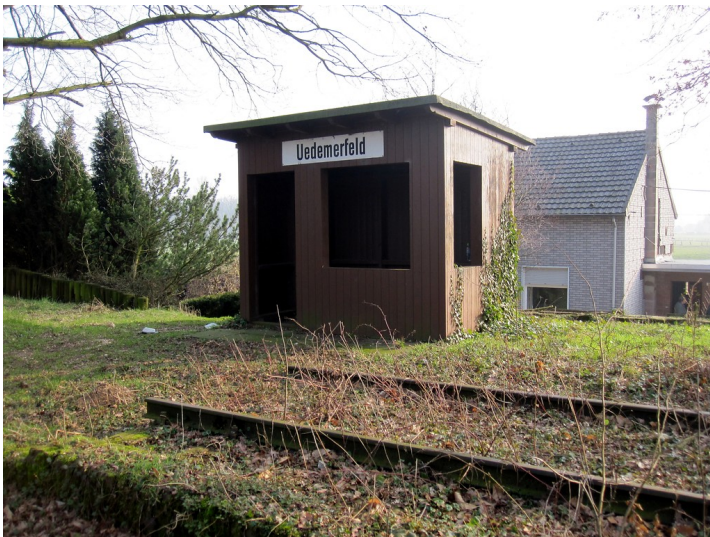
Rekonstruierte Haltestelle Uedemerfeld (2011) Fotograf/Urheber: Burggraaff, Peter
