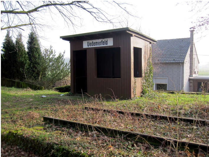
Rekonstruierte Haltestelle Uedemerfeld (2011) Fotograf/Urheber: Burggraaff, Peter
