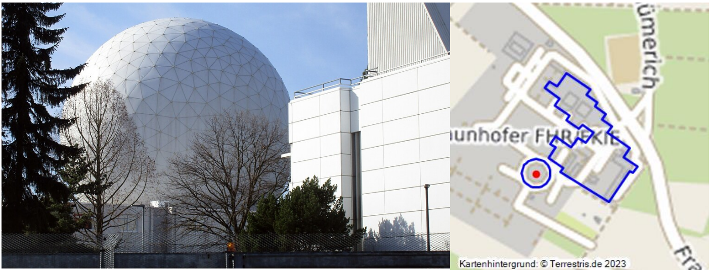
Blick von der Fraunhoferstraße auf die Radarkuppel des "Radar dome" (Radom) des Fraunhofer-Instituts bei Wachtberg-Berkum (2021). Fotograf/Urheber: Franz-Josef Knöchel
