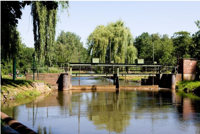
Wehranlage der Zievericher Mühle Fotograf/Urheber: Arendt, Stefan
