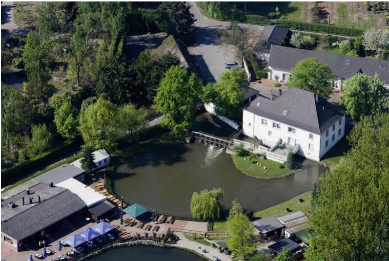
Die Zievericher Mühle mit Stauteich und Wehr Fotograf/Urheber: Arendt, Stefan
