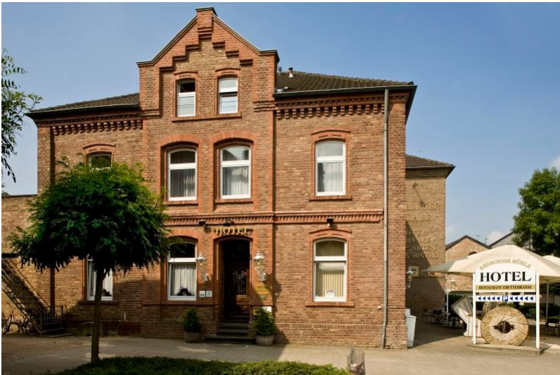
Backsteingebäude der Bedburger Mühle (2009) Fotograf/Urheber: Arendt, Stefan
