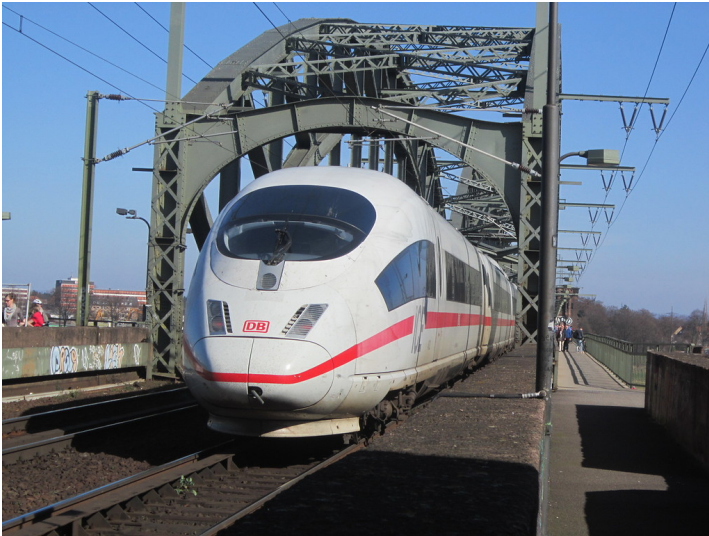
ICE im Umleiterverkehr auf der Südbrücke in Köln (2014) Fotograf/Urheber: Claus Weber
