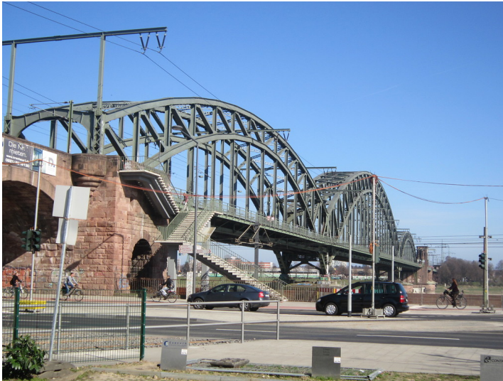
Südbrücke in Köln, vom Gustav-Heinemann-Ufer gesehen (2014) Fotograf/Urheber: Claus Weber
