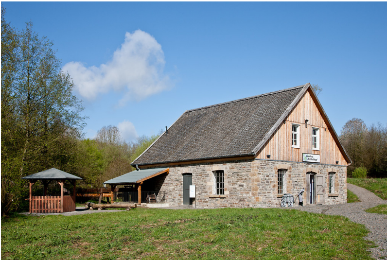
Der Müllershammer im LVR-Freilichtmuseum Lindlar (2012) Fotograf/Urheber: Arendt, Stefan
