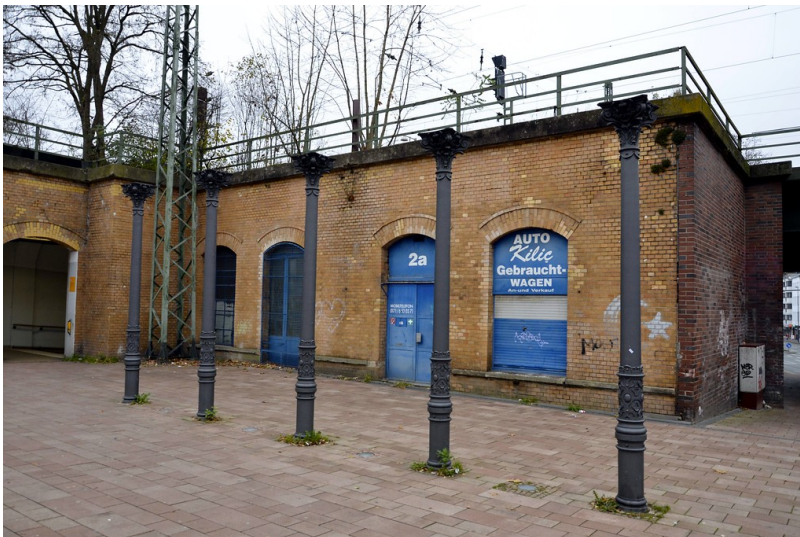
Empfangsgebäude des Bahnhofs Aachen-Rothe Erde (2014), Zugang Robert-Koch-Straße, mit den sanierten und wieder aufgestellten Säulen des ehemaligen Bahnsteigdaches Fotograf/Urheber: Leblebici, Suzan
