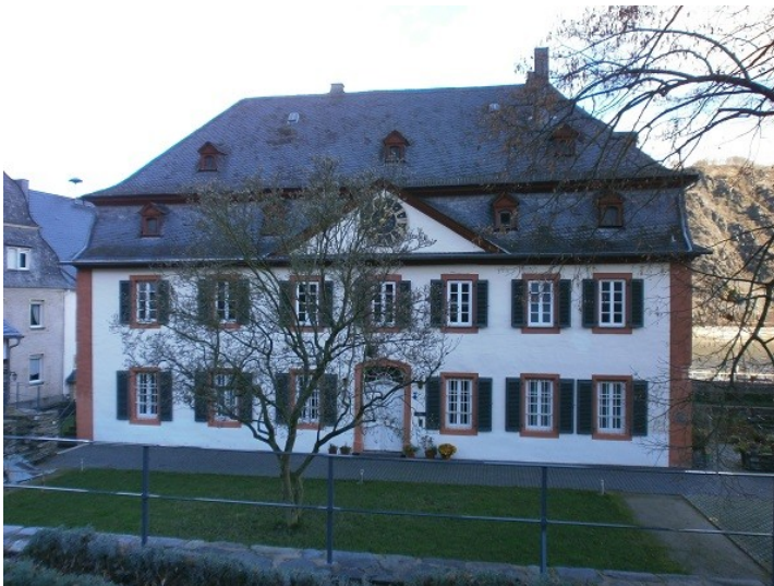
Das heutige Pfarrhaus (ehemals Propsteigebäude) der Propstei Hirzenach in Boppard am Rhein (2014) Fotograf/Urheber: Fertek, Lisa
