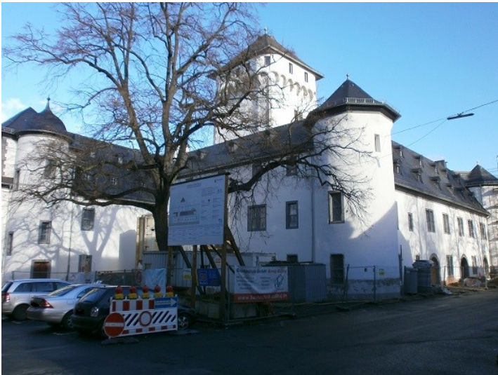
Die Kurfürstliche Burg in Boppard am Rhein während der Sanierung im Jahr 2014 Fotograf/Urheber: Fertek, Lisa
