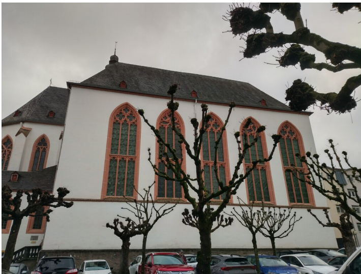
Seitenansicht der Karmeliterkirche (2025) Fotograf/Urheber: Rainer Lahme
