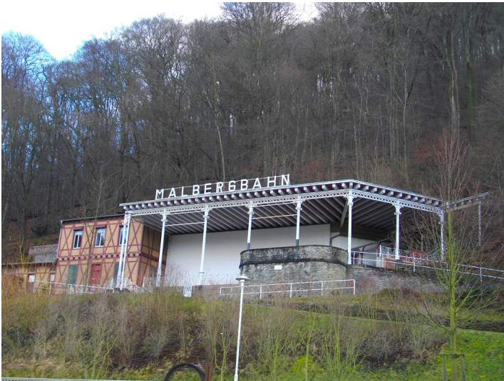
Talstation der Malbergbahn in Bad Ems (2008) Fotograf/Urheber: Pfeiffer, Nina
