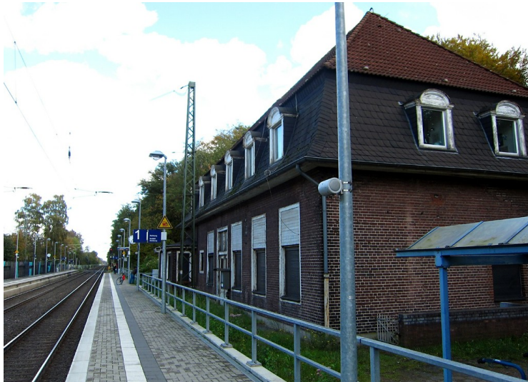
Das Gebäude des Bahnhofs und der Bahnsteig in Krefeld-Forstwald (2013). Fotograf/Urheber: Franz-Josef Knöchel
