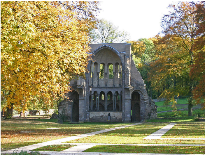
Chorrüine Heisterbach (Zustand 2011) Fotograf/Urheber: Keller, Christoph
