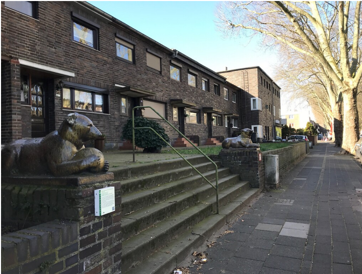
Zwei Bären bewachen die Treppe zur Reihenhauseinheit Typ II mit Kopfbauten am Freiheitsring in Frechen (2020) Fotograf/Urheber: Nicole Schmitz
