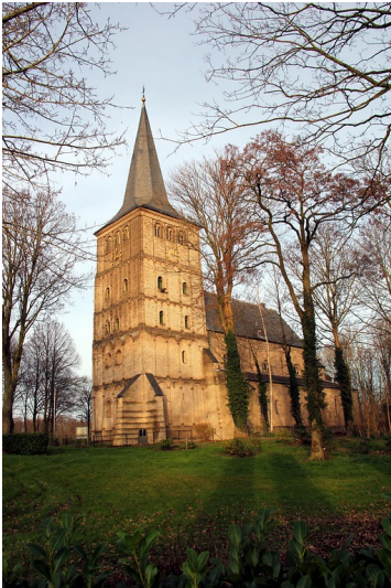
Die ehemalige Stiftskirche und heutige Pfarrkirche St. Vitus in Elten (20159 Fotograf/Urheber: Peter Burggraaf
