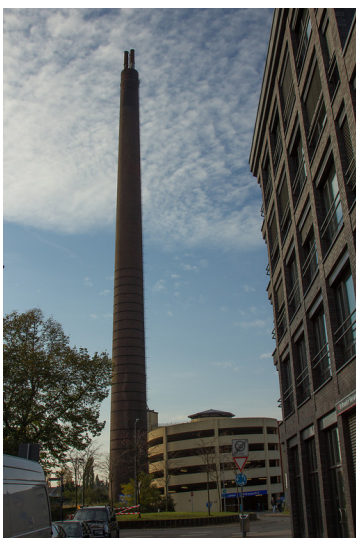
Schornstein der ehemaligen Klöckner-Humboldt-Deutz AG im Kölner Stadtteil Kalk (2013) Fotograf/Urheber: Lagodny, Fabian
