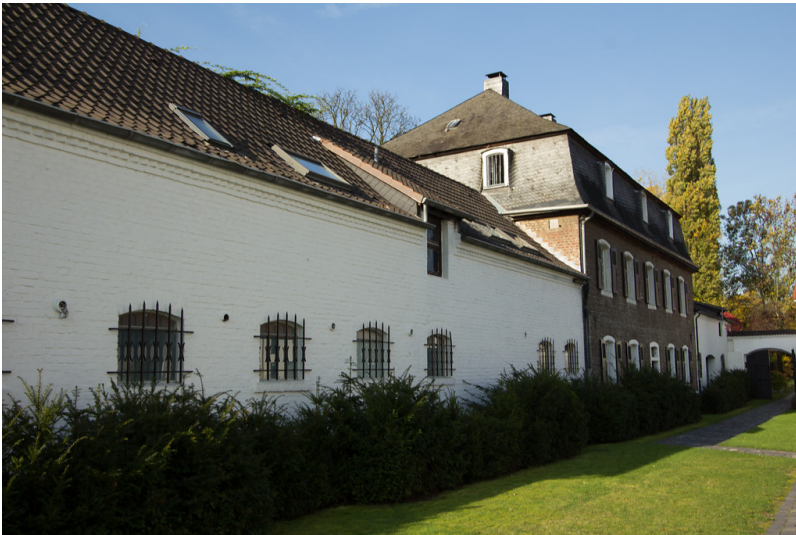
Haupthaus und Wirtschaftsgebäude des ehemaligen Fronhofs in Köln-Merheim (2013) Fotograf/Urheber: Lagodny, Fabian
