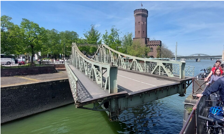
Die 1896 in Betrieb genommene Hafendrehbrücke im Kölner Rheinauhafen öffnet bis heute mit ihrem zwar restaurierten, aber noch historischen Antriebsmechanismus (2023). Fotograf/Urheber: Franz-Josef Knöchel
