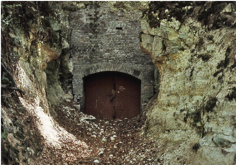
Vermauerter Zugang Fotograf/Urheber: Breuer, Klaus
