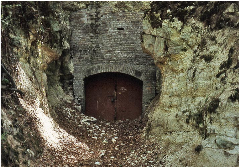
Vermauerter Zugang Fotograf/Urheber: Breuer, Klaus
