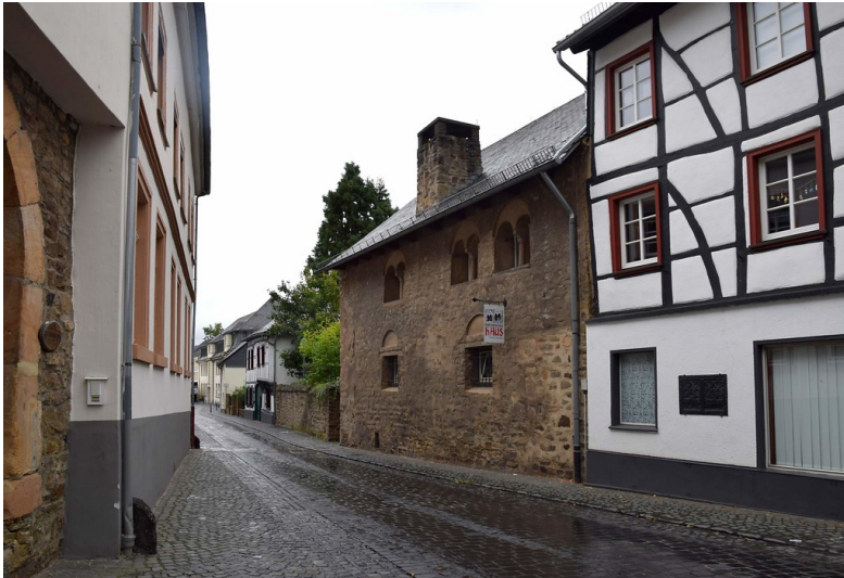
Romanisches Haus in Bad Münstereifel, Blick auf die Straßenseite (2017) Fotograf/Urheber: Karin White-Rahneberg
