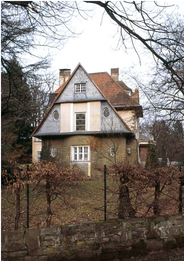
Bergisch Gladbach-Bensberg, Siedlung Alt-Frankenforst Fotograf/Urheber: Jürgen Gregori
