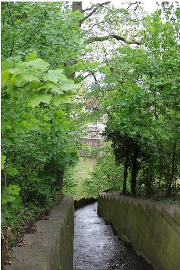
Der ummauerte Graben innerhalb der Klostermauer für die Wasserversorgung (Wasserkraft) des ehemaligen Klosters Maulbronn (2012)
