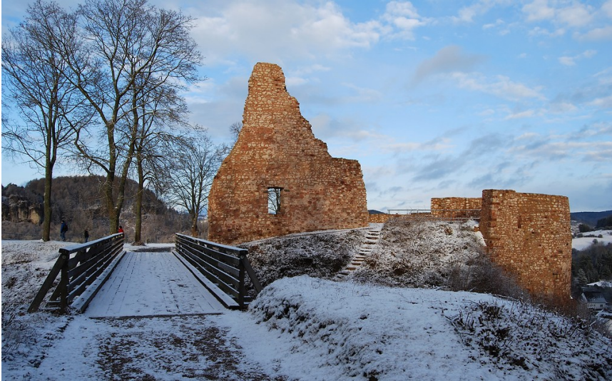
Erhaltene Mauer der Burgruine Löwenburg (auch Gerhardstein oder Junkernburg) bei Gerolstein (2012) Fotograf/Urheber: Felix König
